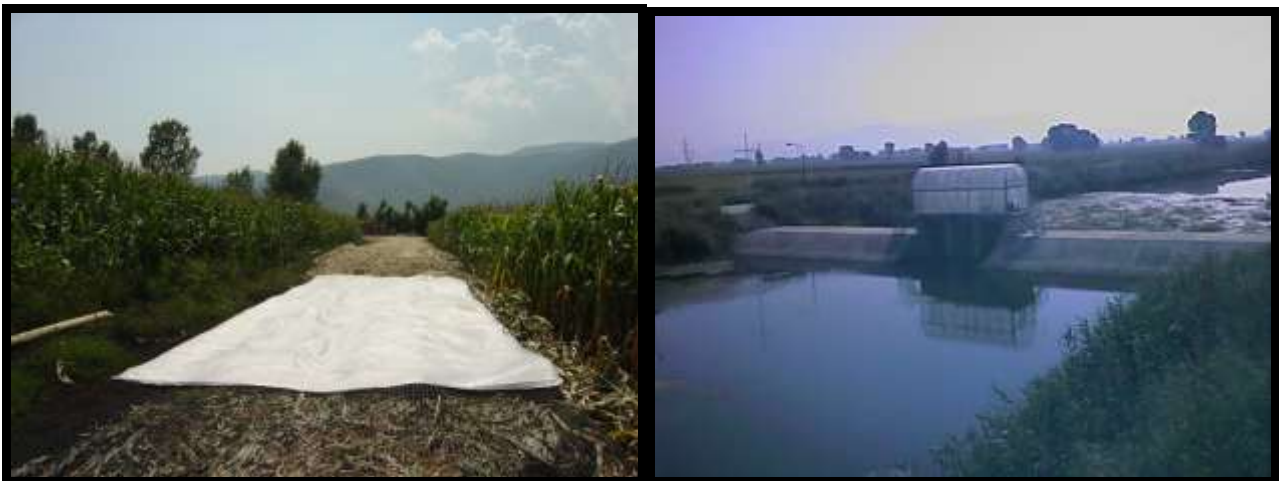
Εικόνα 12. Κατασκευή δρόμων και θυροφράγματα στα Τενάγη (Φωτο: Αρχείο ΔΑΟΚ Καβάλας).
